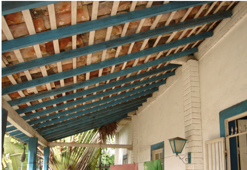
Figura 4- Detalhe do Telhado.
