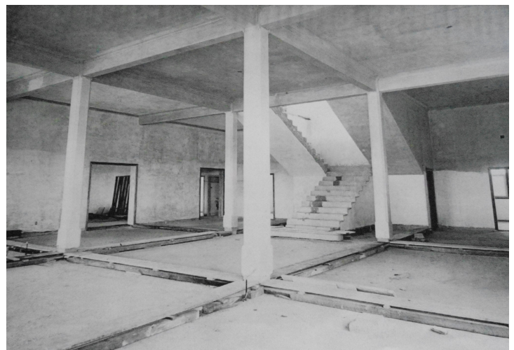
Figura 15 – Vista da escada.
