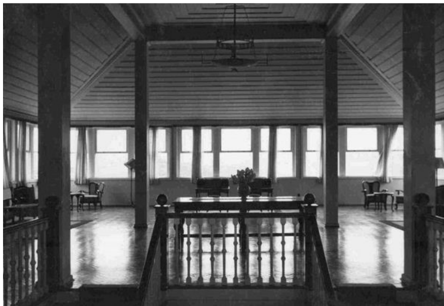
Figura 4 – Acesso ao piso superior.
