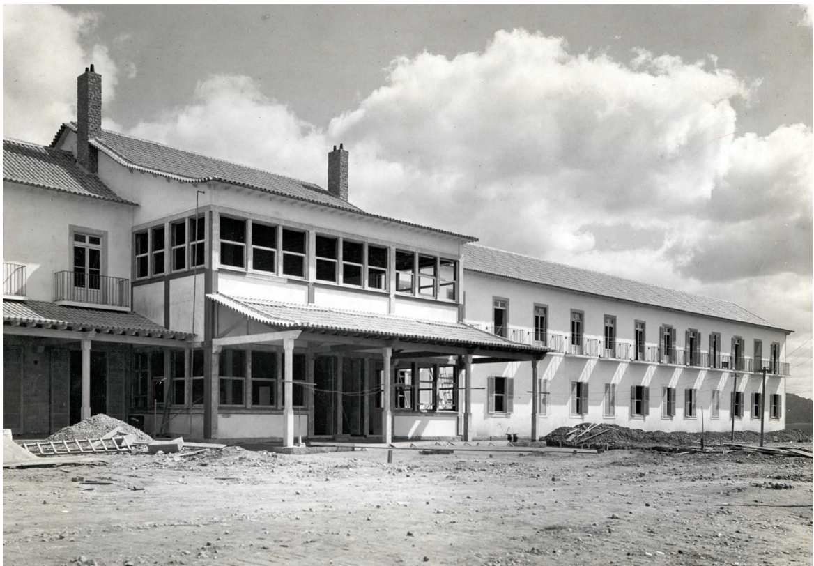
Figura 17 – Finalização da obra.
