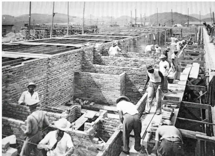
Figura 14 – Execução da alvenaria.
