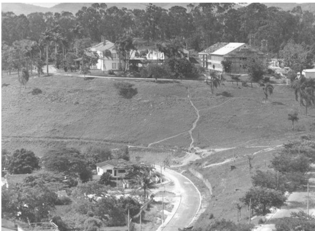
Figura 12 – Vista no período de intervenção, construção do terceiro bloco.
