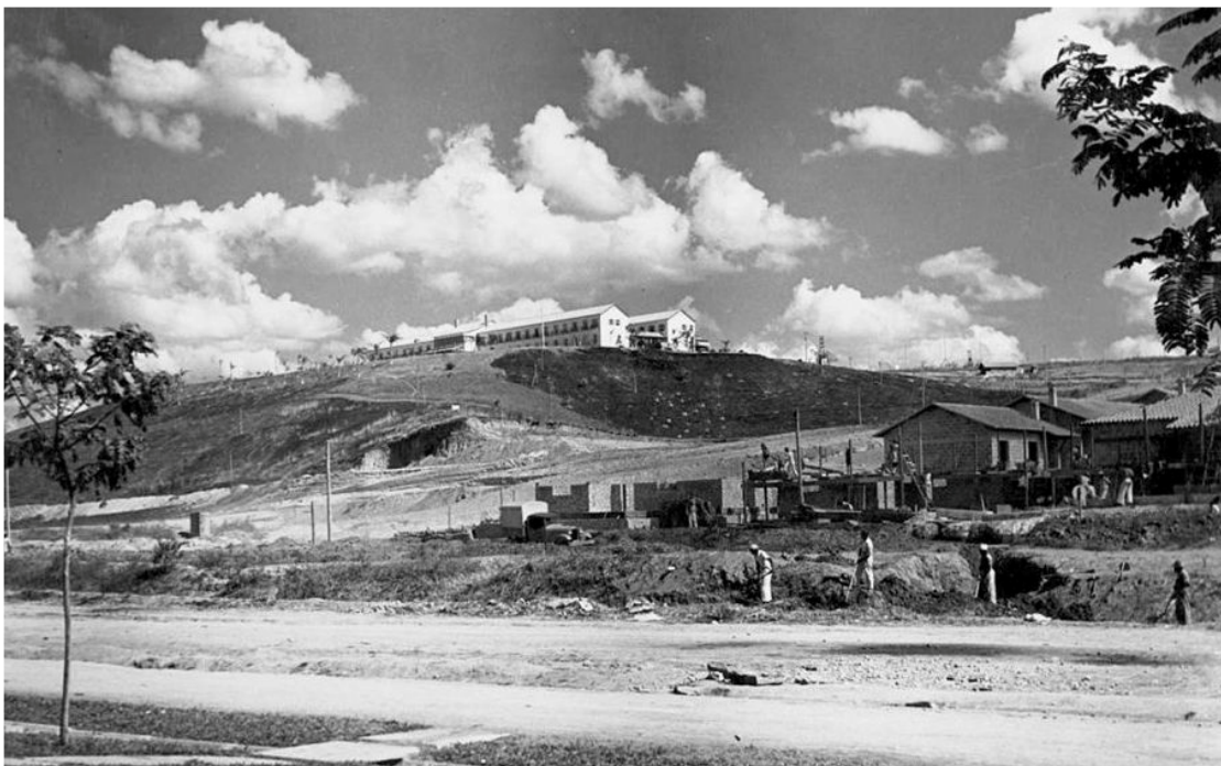
Figura 3 – Vista do Hotel à partir da Rua 21.
