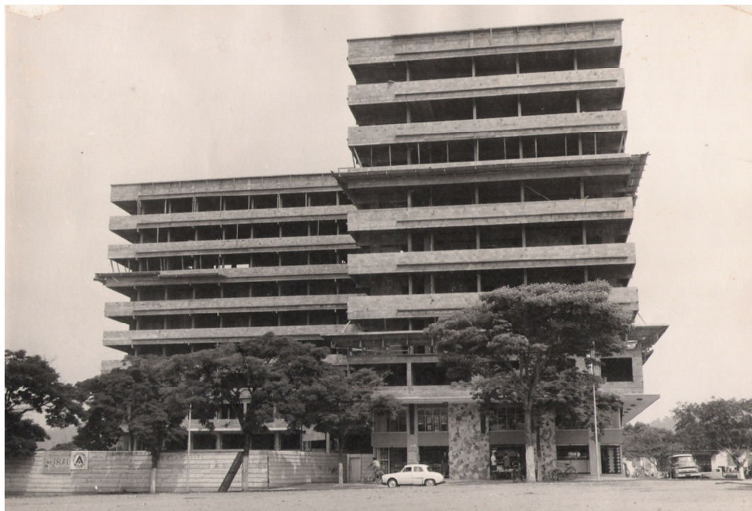
Figura 7 - Edifício GACEMSS em fase de acabamento e as lojas em funcionamento, 1963.
