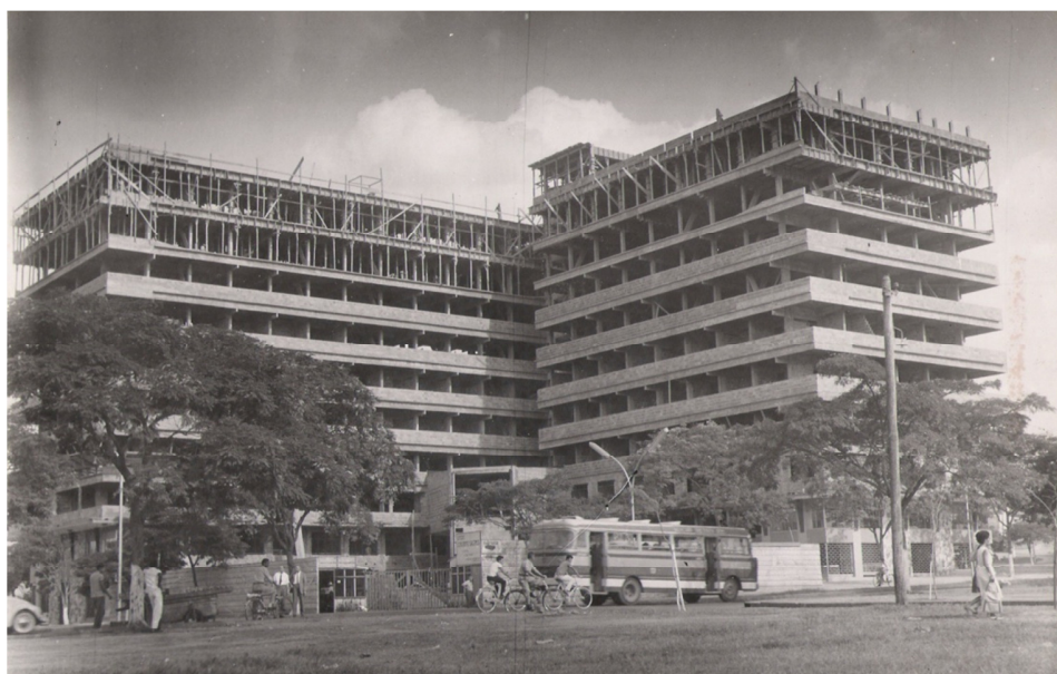
Figura 12 - Edifício GACEMSS - Em construção 1962.
