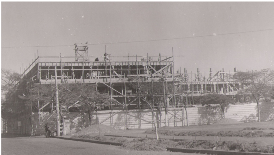
Figura 11- Edifício GACEMSS - Em construção 1961.
