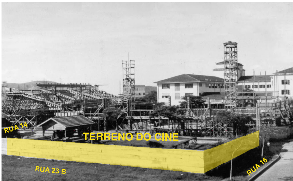
Figura 35 - Início das obras de construção do Cine.
