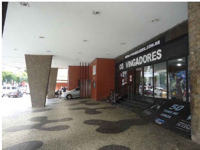
Figura 11 – Calçada da Fachada Principal.
