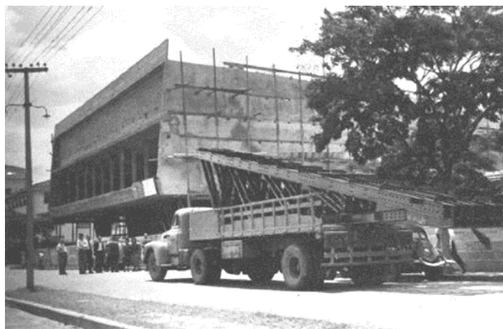
Figura 23 – Fase de acabamento, 1959.
