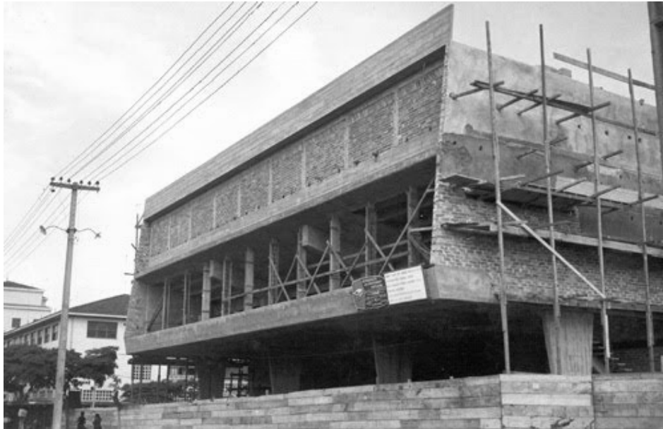
Figura 37 - Estágio alvenaria das obras de construção do Cine.
