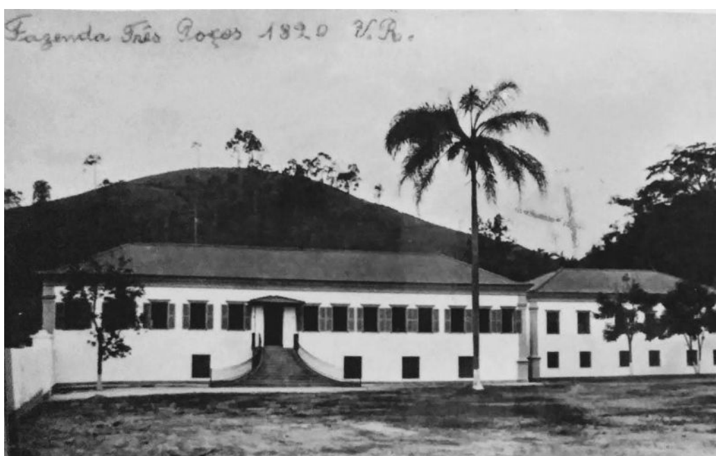
Figura 7 - Sede da Fazenda Três Poços, final do século XIX
