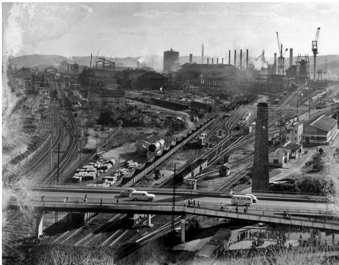
Figura 23 - Vista do Viaduto e atrás a Chaminé década de 1970
