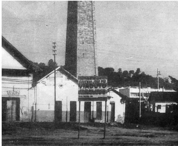
Figura 2 – Construção do Viaduto N. Sra. das Graças, década de 1960.
